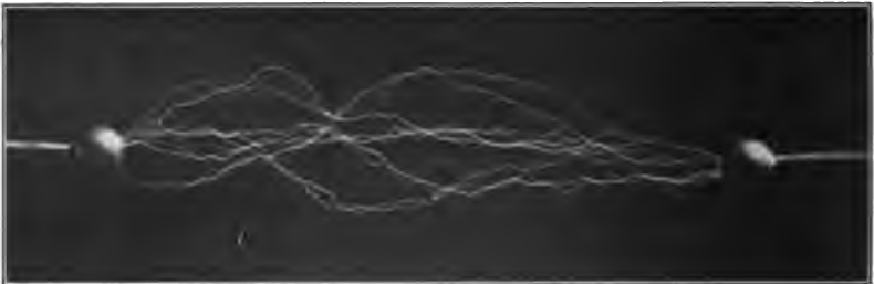
Abb. 279. Aktive Funkenentladung eines Transformators.
